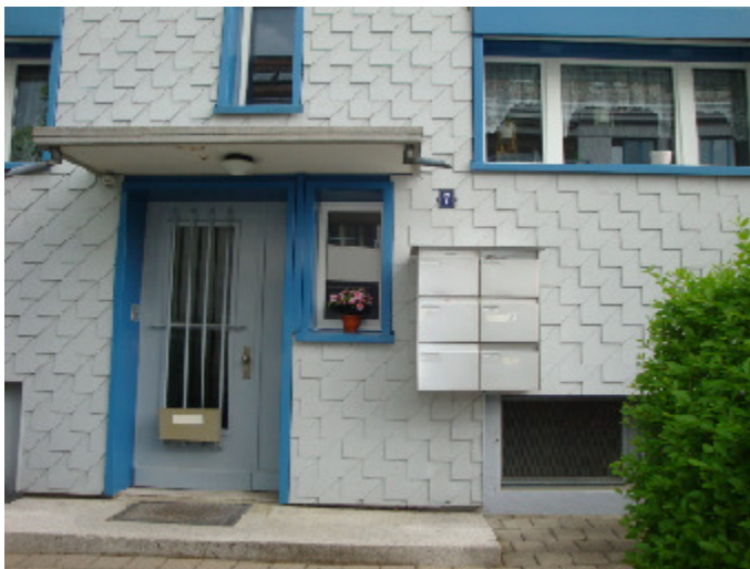
Fehlender externer Türraum. Viktoriastr. 7, 8057 Zürich
